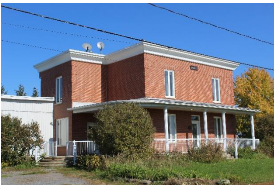
Maison à toit plat Tous milieux.
