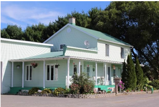
Maison vernaculaire de deux étages
