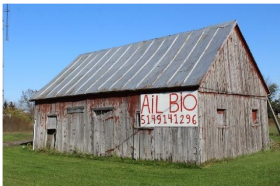
Bâtiment à toit à deux versants Milieu rural.
