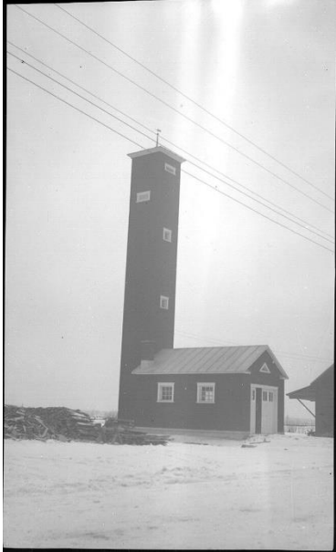
Caserne de pompiers de Sainte-Marie-Salomé construite en 1941. Source : Image tirée des dossiers de la MRC de Montcalm.
