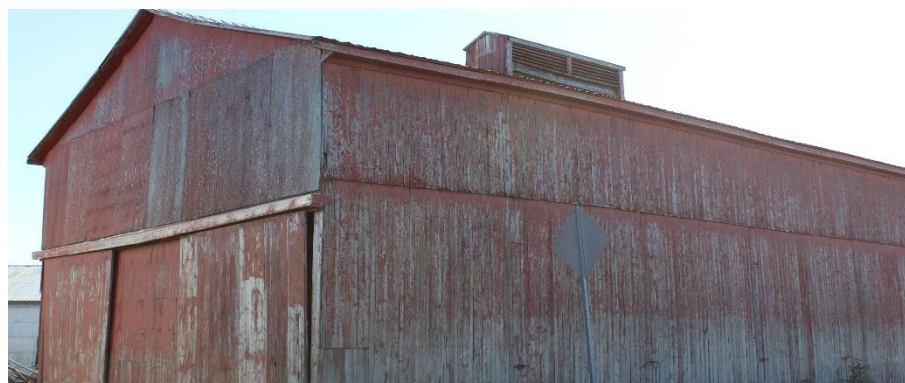
Bâtiment agricole à Saint-Roch-Ouest. Source : inventaire du patrimoine de la MRC de Montcalm, phase 1, 2021.
